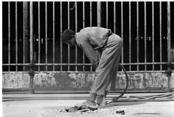
Travaux de voirie, Paris, 6 novembre 1971
