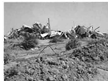
Al Arakib, 31 janvier 2011 (images de la 11 e démolition)
