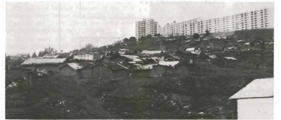
Se loger dignement : un effort à poursuivre
