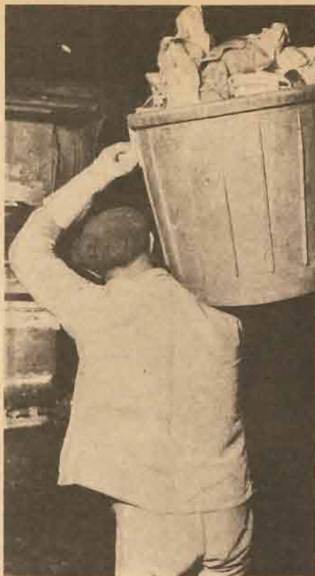
Les travaux les plus pénibles.
