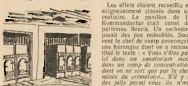
Les fours crématoires
